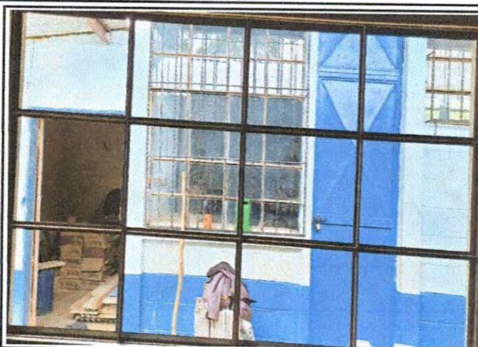
Foto 2: Instalacion de ventanas al módulo de cocina.
