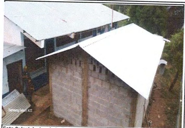
Foto 2: Instalación de techo.
