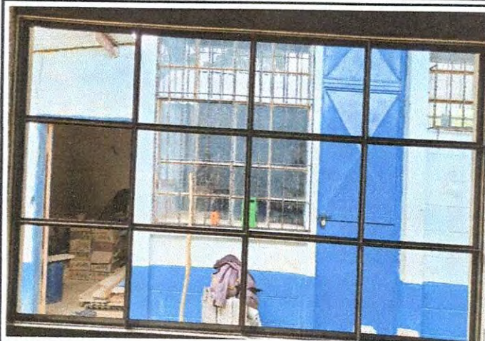
Foto1: Mejoramiento de ventana al módulo de cocina.
