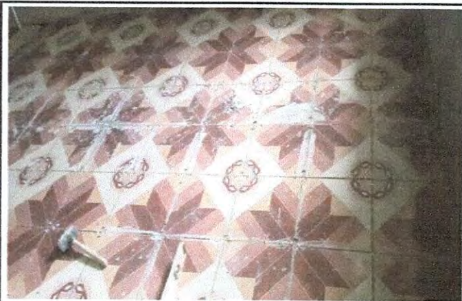
Foto 3: Avances en la instacion de piso Cerámico del módulo de cocina.
