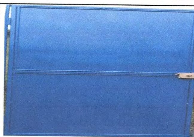
Foto 3: Instalación de puerta al módulo de cocina
