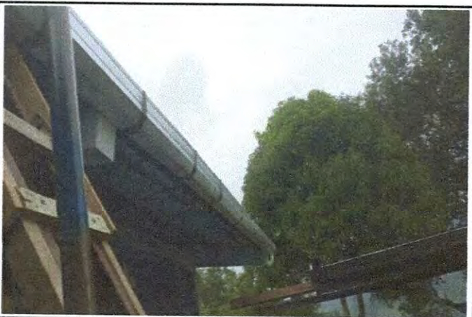
Foto 3: avances en la Instalación de canales y bajada de agua
