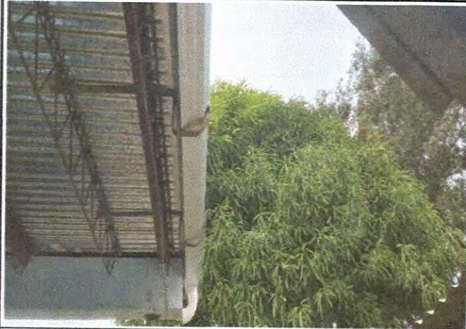
Foto1: Mejoramiento de Canales y bajada de agua.
