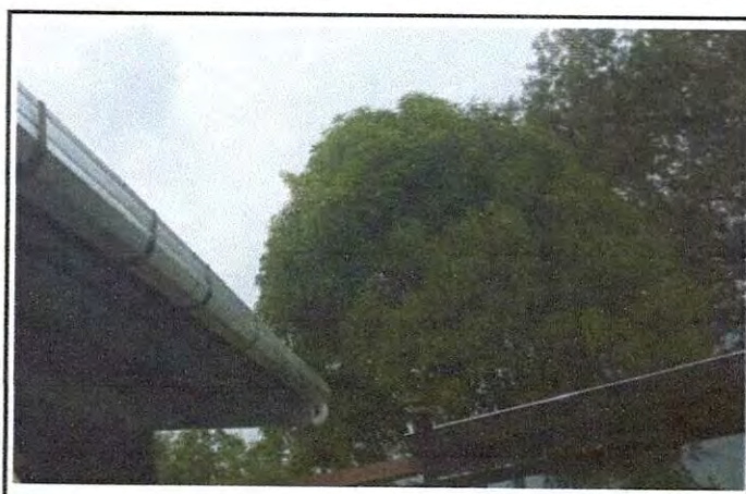
Foto 4: Finalización de meroramiento de calales y bajada de agua lluvia. 17-12-2024
