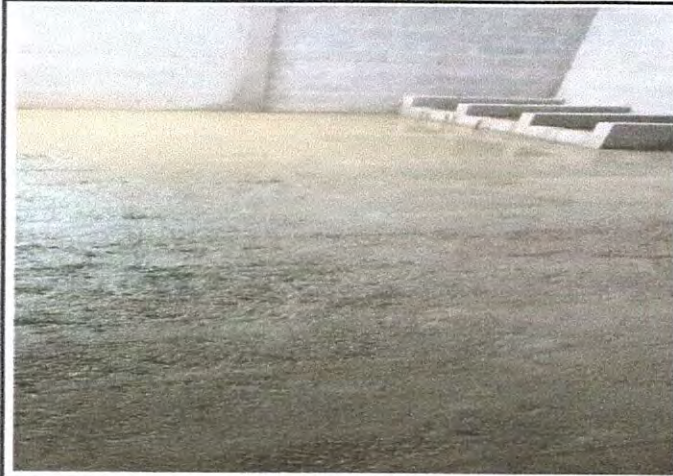
Foto 1: Mejoramiento de piso de concreto al módulo de cocina
