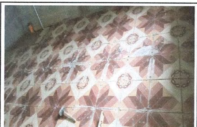
Foto 4: finalización de mejoramiento de piso Cerámico al módulo de cocina. 17-12-2024
