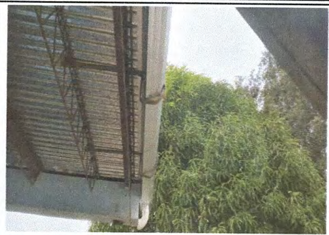
Foto 2: Instalacion de canales y bajada de agua.
