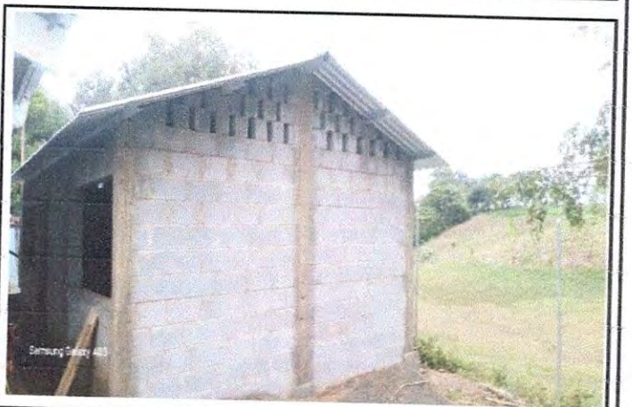
Foto 4: Pared y techo finalizado.
